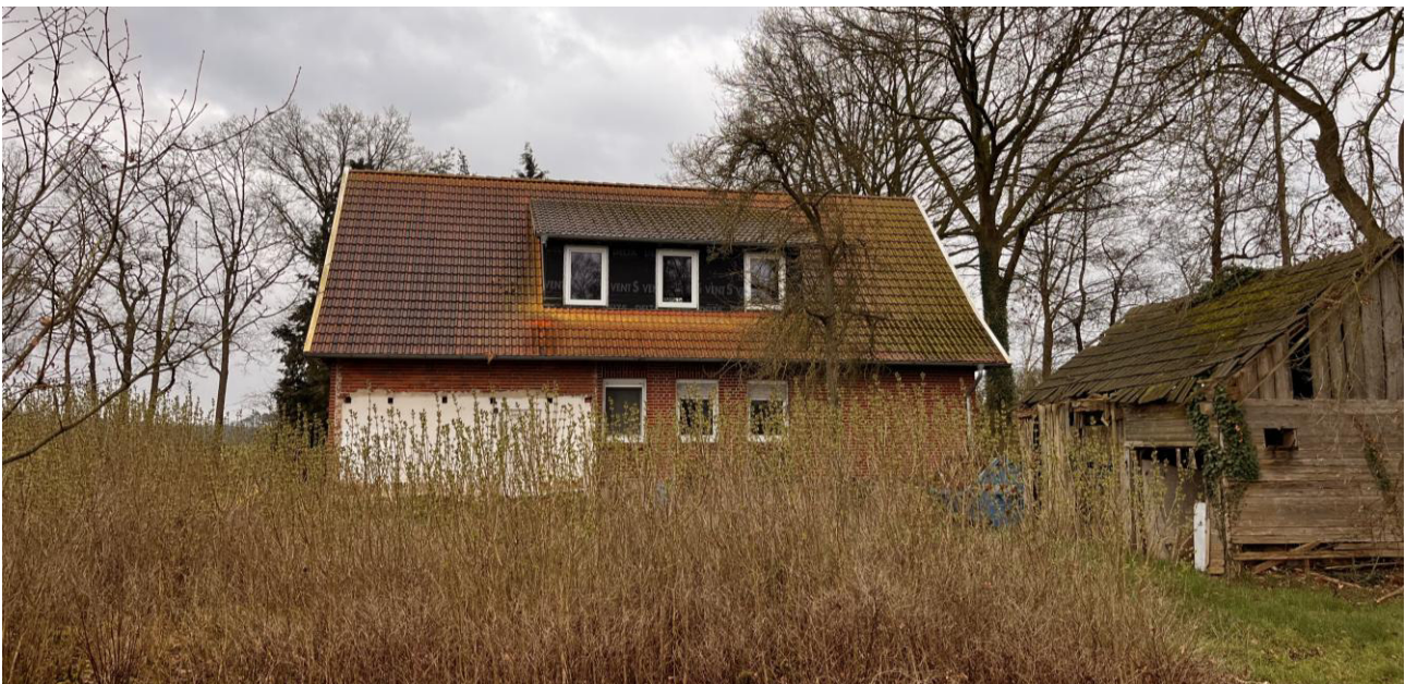
Abbildung 13: Nordwestliche Fassade des Hauses am Mühlenweg 2 (Quelle: Auftraggeber)
