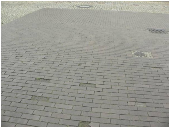
Pflasterschäden
