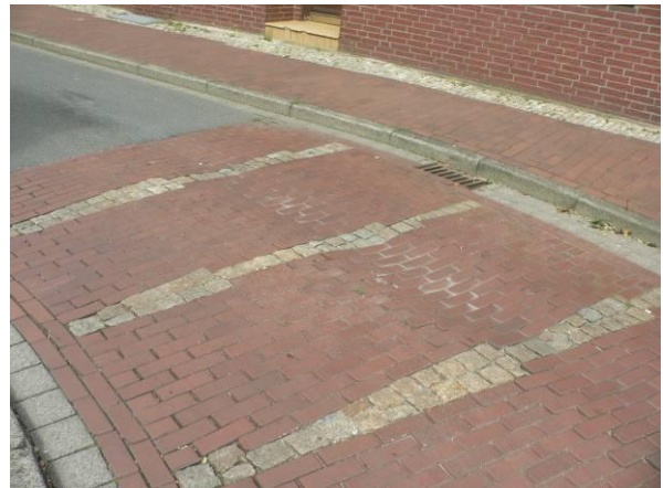
Pflasterverformung
